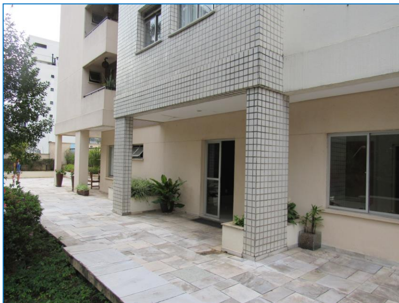
Foto de nº 24 - Acesso ao edifício.
