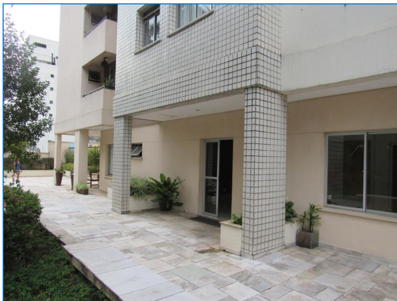
Foto de nº 24 - Acesso ao edifício.
