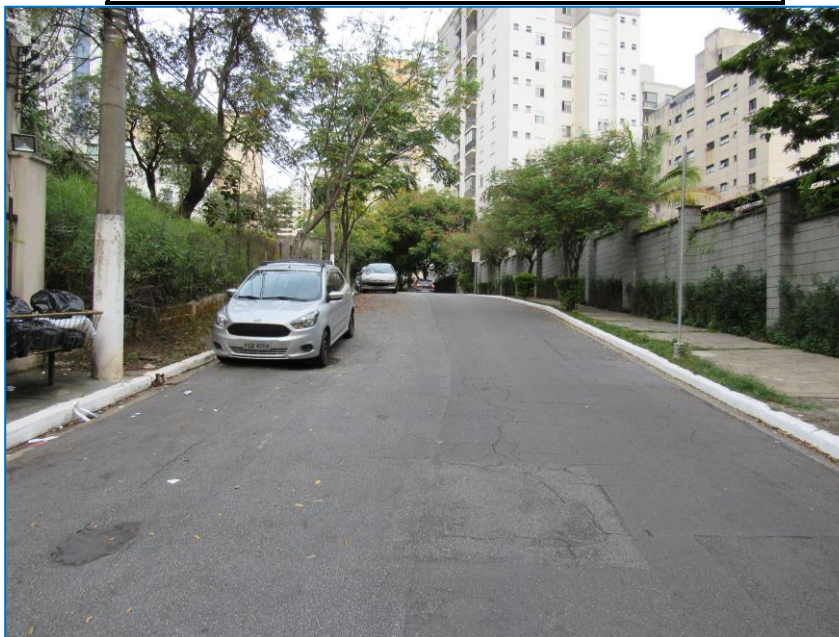
RUA DELEGADO MORAES NOVAES, NO TRECHO ONDE ESTÁ SITUADO O EDIFÍCIO NEW ORLEANS.
