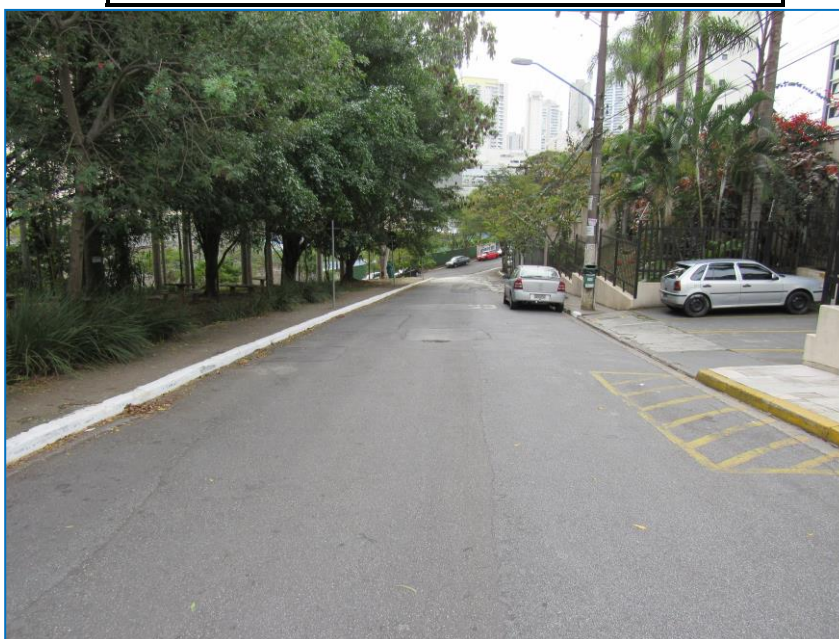
RUA DELEGADO MORAES NOVAES, NO TRECHO ONDE ESTÁ SITUADO O EDIFÍCIO NEW ORLEANS.
